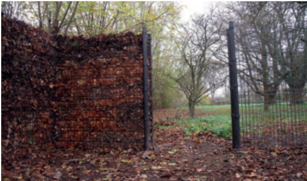
Voor de bouw van deze bladwand werd gekozen voor stevig, decoratief raillierwerk gemonteerd tussen metalen palen.
