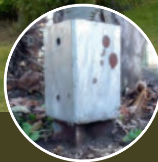
Omdat palen – zeker als ze onbehandeld zijn – het snelst rotten in de bovenste 10 à 20 cm van de grond, is het veiliger om constructies die lang moeten meegaan in speciale ankers te plaatsen.
