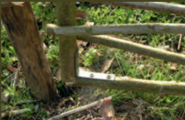
Deze grote poort heeft enkel wat schroeven en hoekijzers gekost. Om te voorkomen dat ze doorbuigt, werd ze met een kabel opgehangen aan de hoge hoekpaal.
